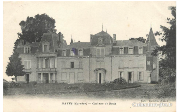
Ill. 7. Château de Bach, Naves, Corrèze
